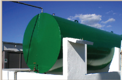
대체연료를 저장하는 연료탱크. (46,000 liters) The tank with alternative fuel (46,000 liters)
